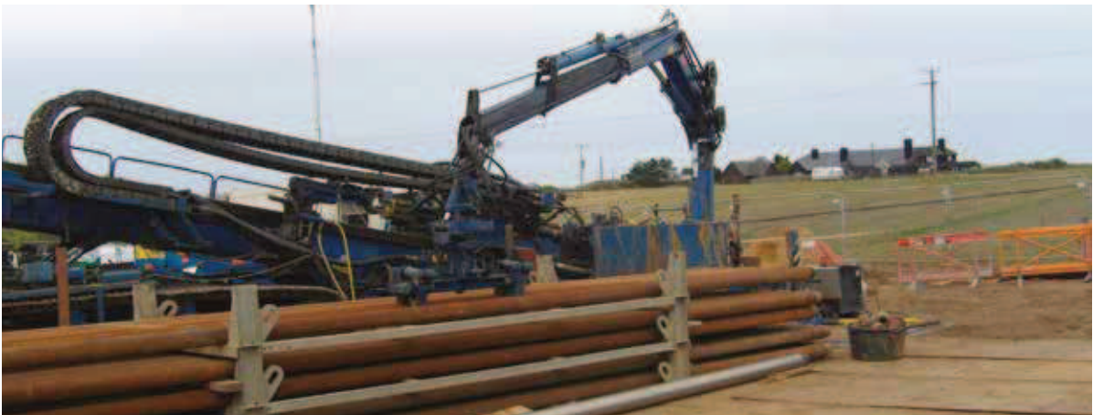
Example HDD rig
